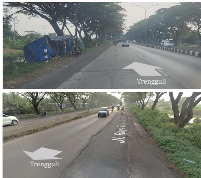
Gambar 1. Retak Memanjang pada Jalan Trengguli-Kudus (Sumber: Google Earth, 2023)
