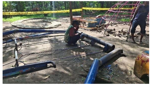
Gambar 4. Perabot yang Diperbaiki di Lokasi area Bermain Akibat Sambungan Permanen.
