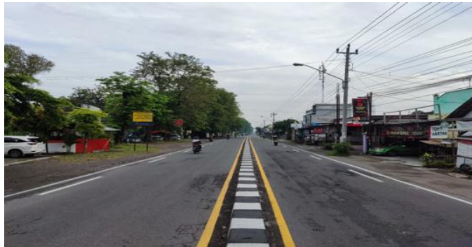
Gambar 3. Kondisi Jalan Bantul Km 6,5 – 7,5 eksisting setelah preservasi 2022 (4/2-T tidak standar)
