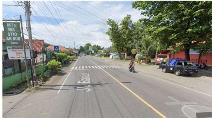
Gambar 5. Kondisi Jalan Bantul Km 6,5 – 7,5 sebelum preservasi 2022 (2/2-TT standar) sumber: maps.google.com
