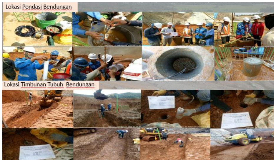
Gambar 7. Dokumentasi pemasangan piezometer pada lokasi tubuh bendungan (sumber: dokumentasi lapangan)
