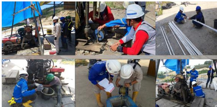
Gambar 13. Pemasangan observation well (sumber: dokumentasi lapangan)
