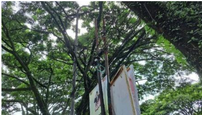
Gambar 2. Kondisi Fasilitas Penerangan
