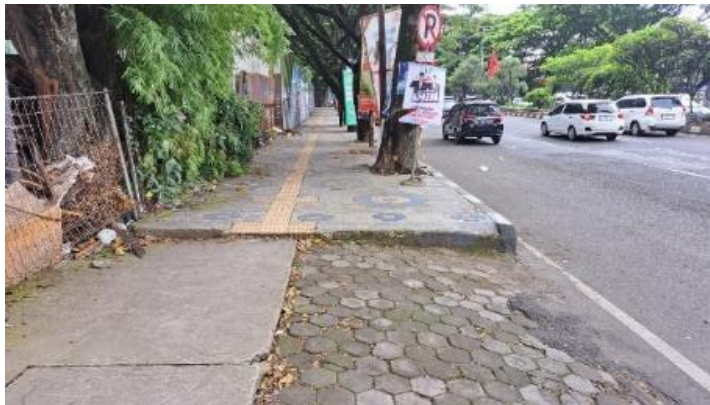
Gambar 7. Kondisi Akses Keluar Masuk Kendaraan
