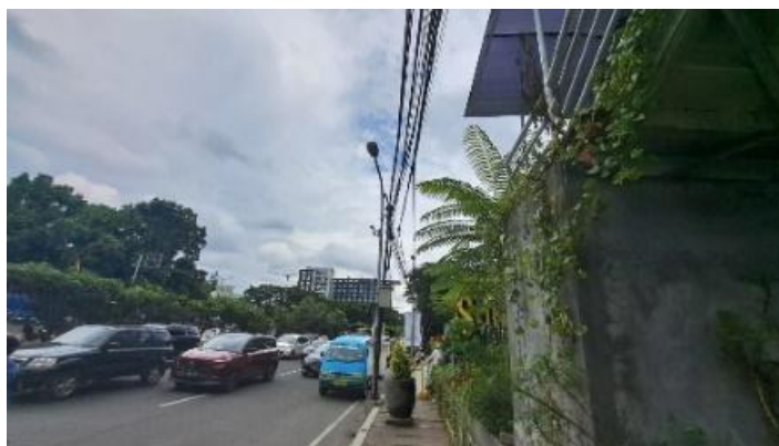
Gambar 5. Kondisi Fisik Lampu Penerangan
