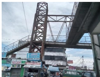
Gambar 9. Jembatan Penyeberangan di Area Terminal
