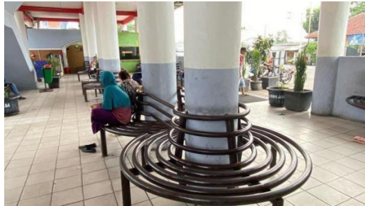
Gambar 5. Kondisi tempat duduk
