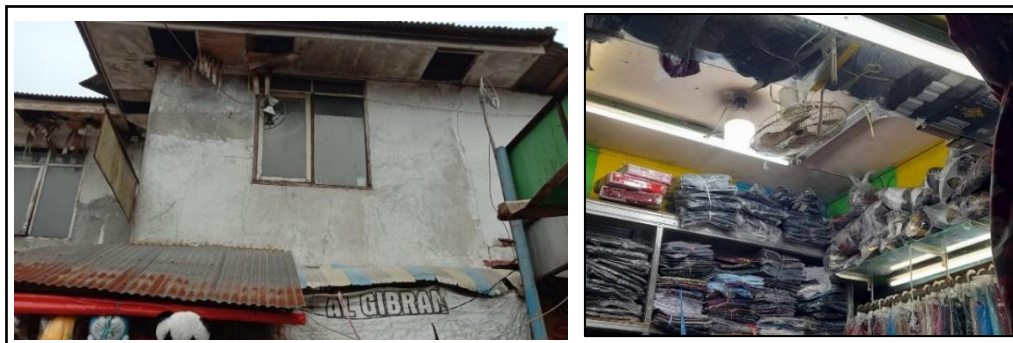
Gambar 2. Ventilasi Alami dan Buatan di Pasar Ciparay
