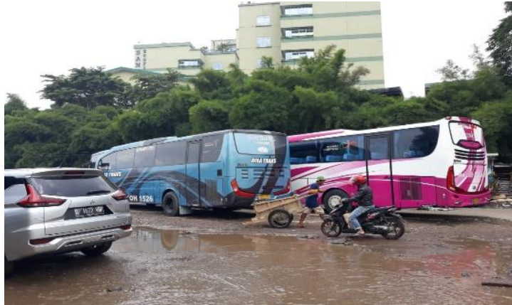
Gambar 2. Jalan Tempat Parkir Kendaraan di Pintu Selatan Stasiun
