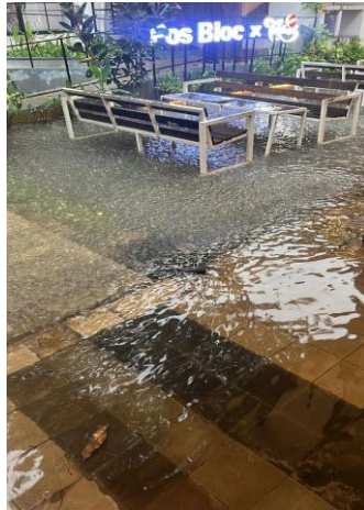
Gambar 1. Kondisi banjir di area Pos Bloc
