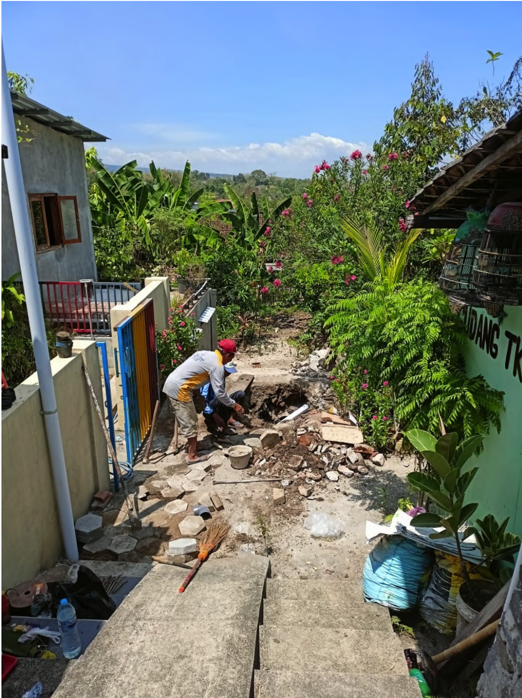
Gambar 5 Pemasangan Sumur Resapan.
