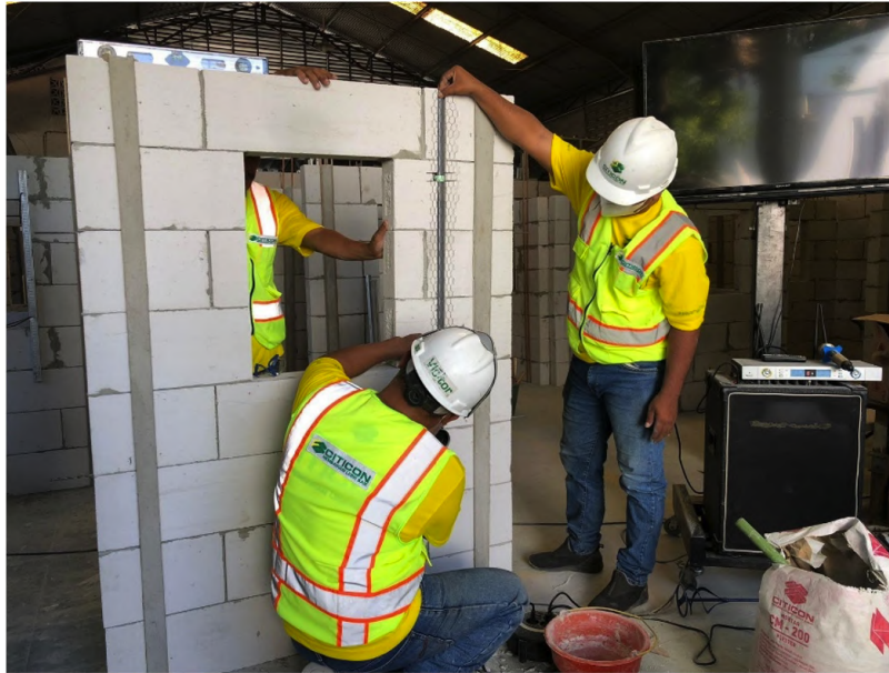
Gambar 7 Praktik pemasangan jalur kelistrikan.
