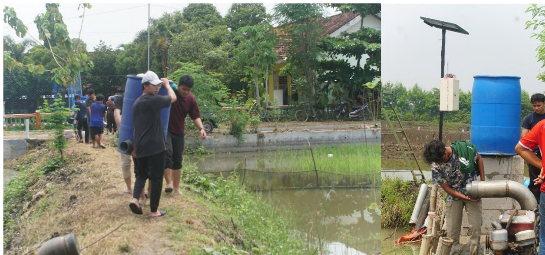
Gambar 5 Pemasangan Sistem Monitoring dan Filter Air di Desa Sidobinangun.
