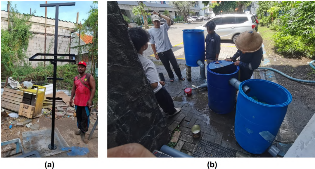
Gambar 4 (a) Perakitan Kerangka Panel Box dan Photovoltaic , (b) Perakitan dan Pengujian Sistem Filter Air.
