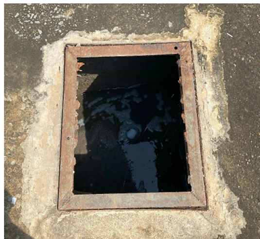
Gambar 9 Pembuatan Lubang Serapan untuk Limbah Cair
