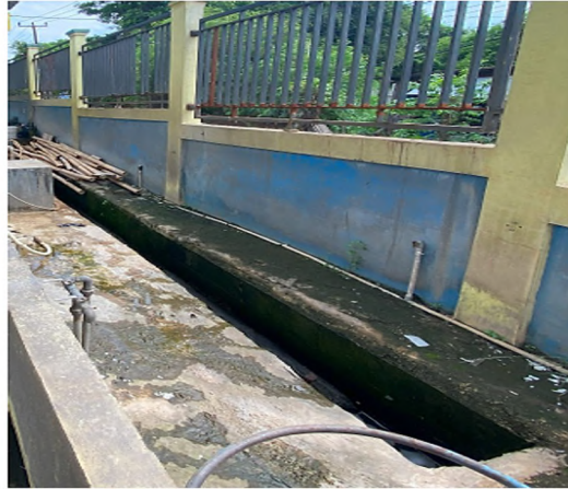
Gambar 8 Pembuatan Saluran Pemisah Pembuangan Limbah Cair di Bengkel May Car Bodyworks.
