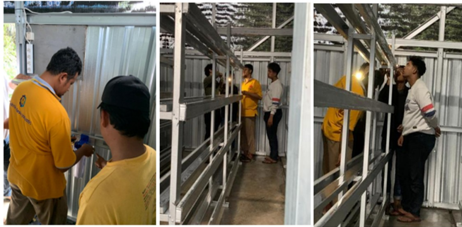
Gambar 7 Pemasangan instalasi penyiraman otomatis.
