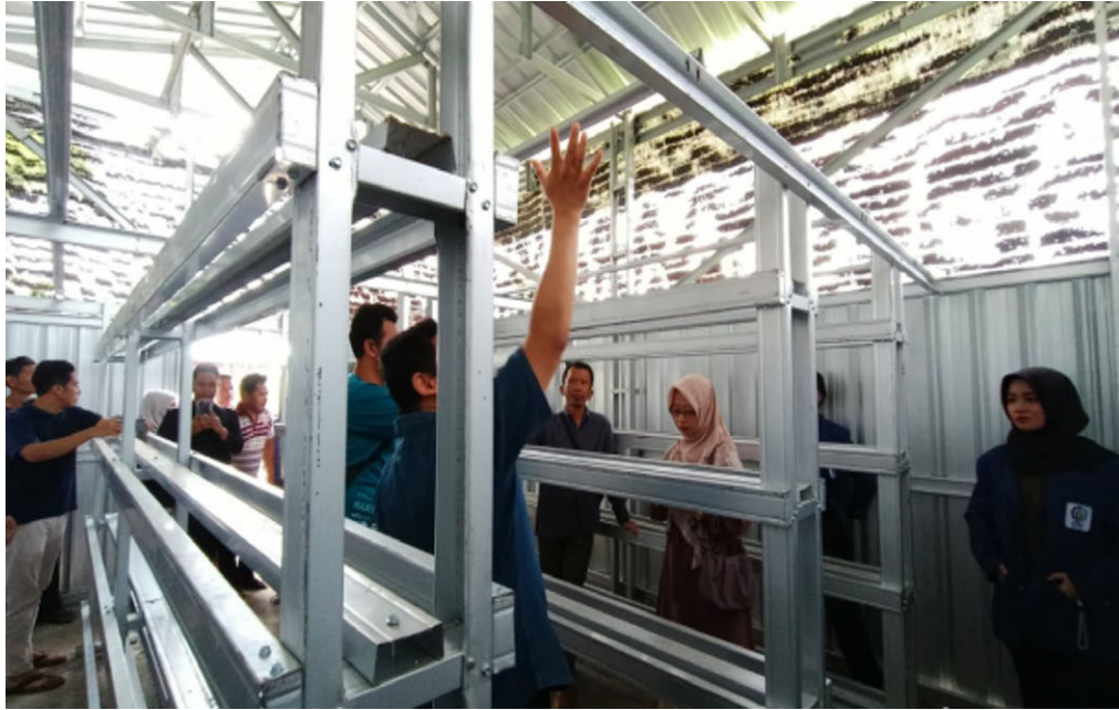
Gambar 5 Monitoring pembuatan kumbung jamur.
