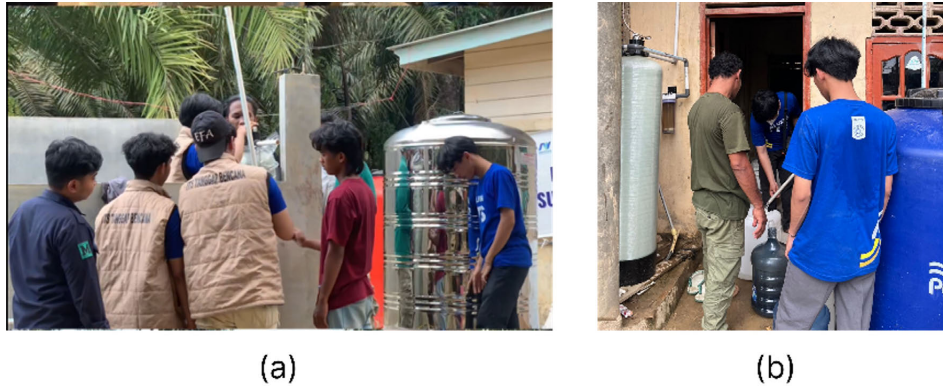
Gambar 3 (a) Pemasangan Filter Air Pada Mushola di Desa Bandar Mahligai (b) Pemasangan Sistem Reverse Osmosis di Desa Kampung Dalam.
