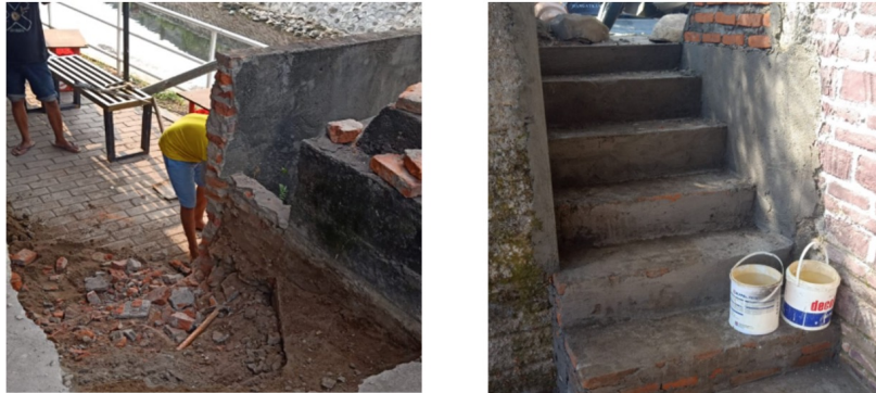
Gambar 15 Proses pembangunan tangga untuk akses menuju lokasi dapur di lantai dasar.
