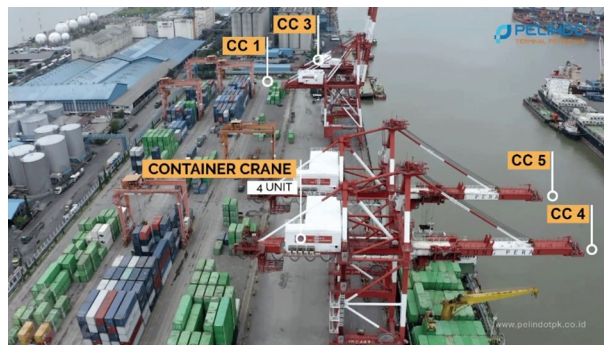
Gambar 2 Fasilitas Pelabuhan yang ada di Terminal Nilam.
