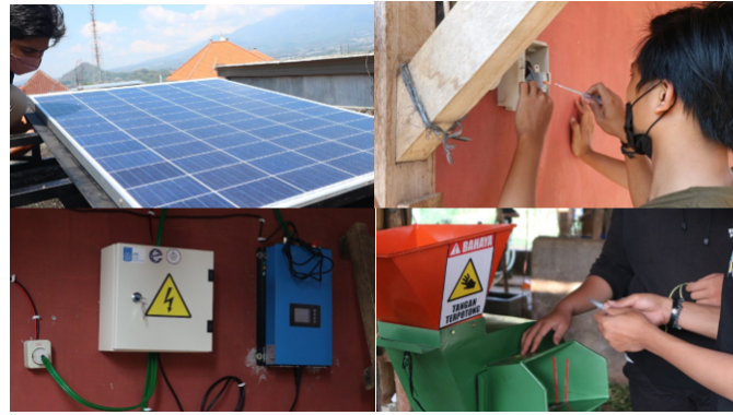
Gambar 6 Proses pemasangan solar panel dan instalasi kelistrikan.
