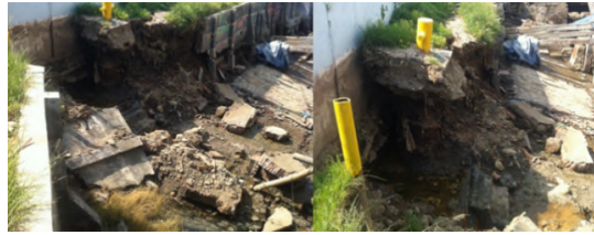
Gambar 3 Kerusakan dinding graving dock sisi barat pada tahun 2017.
