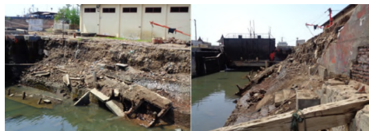
Gambar 2 Kerusakan dinding graving dock sisi timur pada tahun 2016.
