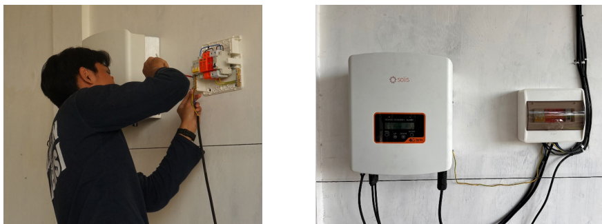
Gambar 11 Pemasangan Alat pada Lokasi Mitra.
