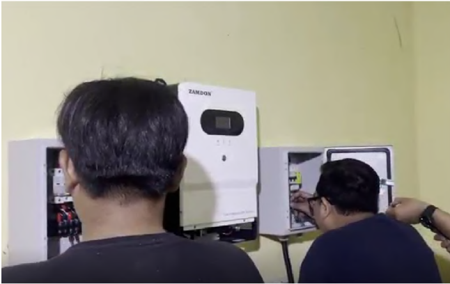
Gambar 7 Pemasangan mesin penyortir biji kopi otomatis dan sistem PLTS hybrid .
