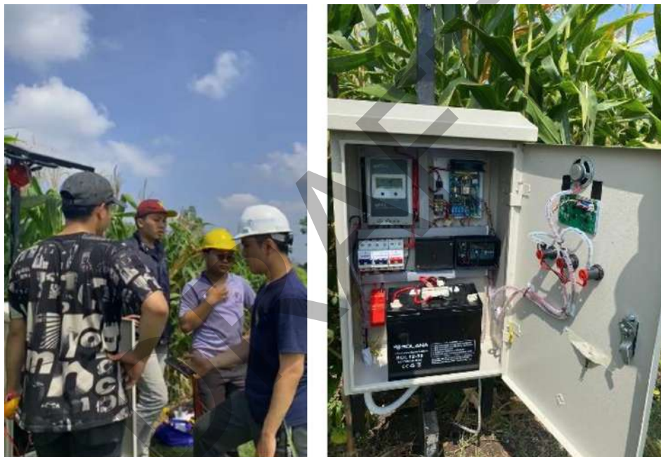
Gambar 8 Commissioning Alat di Area Persawahan
