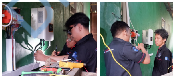
Gambar 13 Instalasi Inverter dan Panel Hubung Bagi.
