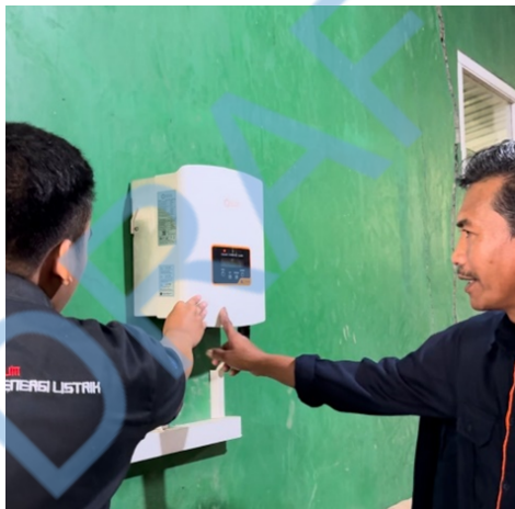
Gambar 16 Pendampingan Uji Coba Pengoperasian PV on-grid .
