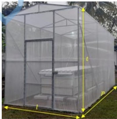
Gambar 8 Pembangunan Green House .
