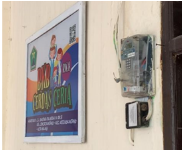
Gambar 5 Alat kWh meter lama Pos PAUD Kasih Bunda.
