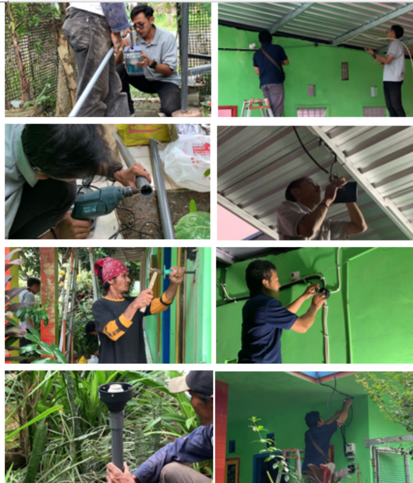
Gambar 7 Proses pemasangan lampu taman otomatis.
