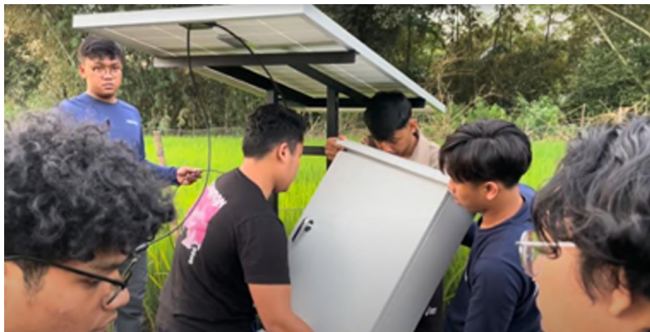
Gambar 4 Pemasangan panel box dan alat smart farming pada kerangka photovoltaic .
