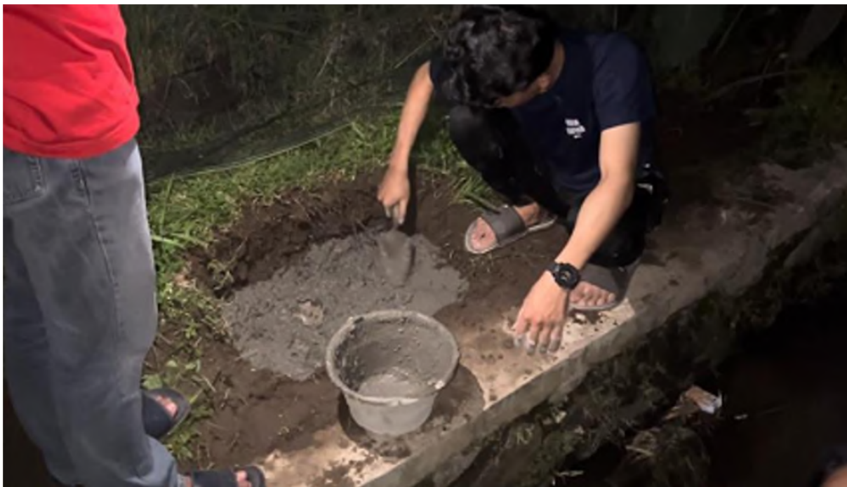
Gambar 2 Pengecoran alas kerangka photovoltaic .
