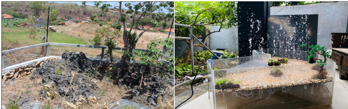
Gambar 4 Area pembangunan dancing water dan Desain prototype .
