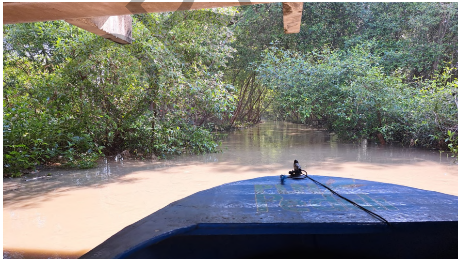
Gambar 4 Kondisi aktual lebar kanal area pemukiman kompleks Grand Island Pakuwon City.
