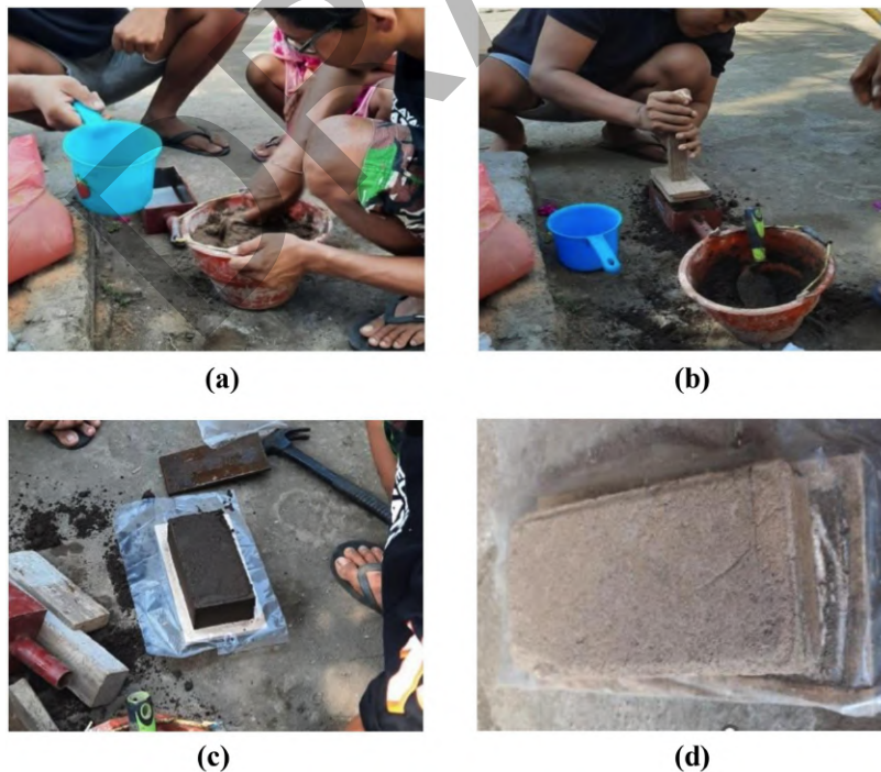
Gambar 5 Proses pelatihan: (a) Mencampur semen dengan tanah; (b) Proses pencetakan dan pepadatan blok; (c) Blok dikeluarkan dari cetakan; (d) Kondisi blok dalam keadaan kering.
