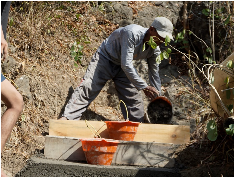
Gambar 9 Proses Pengecoran Tangga.
