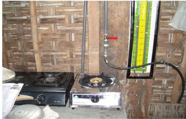
Fig 6 Pemasangan kompor gas dan digester setelah diisi dengan kotoran sapi dan dibiarkan selama 2 minggu sudah terbentuk biogas dengan diamati terjadi perbedaan tekanan yang ditunjukkan pada alat manometer. Kompor menyala setelah disulut api dengan korek api.
