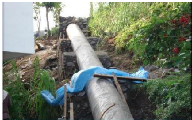
Fig. 5. Pipa Pesat PLTMH
