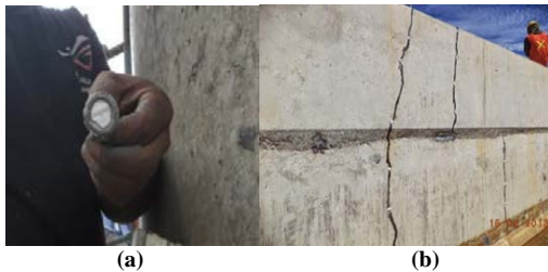
Gambar 10. (a) Nipel injeksi (b) Pemasangan Nipel Injeksi.
