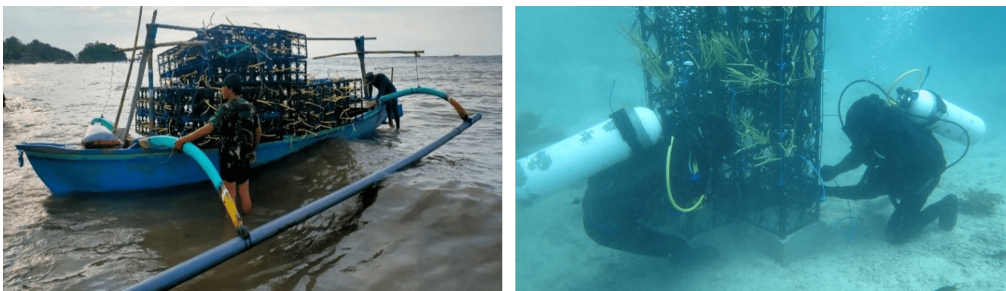
Gambar 6 Kegiatan tindak lanjut dari workshop dan FGD: perakitan dan peletakan unit rumah ikan ( fish apartment ) di perairan Kembangsambi, Situbondo.
