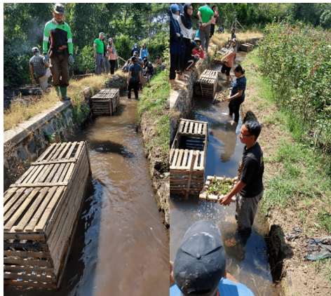
Gambar 6 Instalasi floating bamboo tanaman Biofiltrator Melati Air E. radicans , pada keramba ikan budidaya ikan Nila Dusun Kajar.
