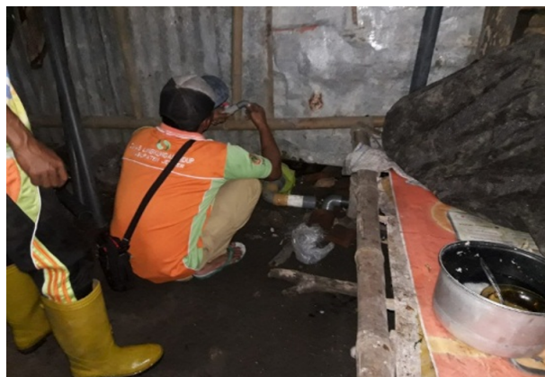
Gambar 7 Pemasangan Kompor Biogas dan uji coba Kompor.
