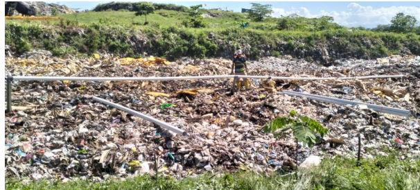
Gambar 6 Proses pemasangan pipa.
