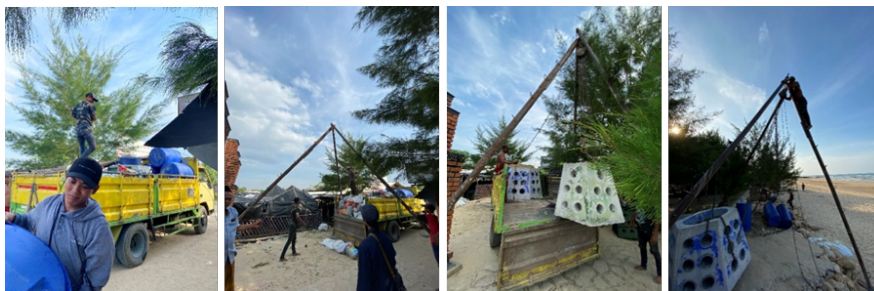
Gambar 9 Proses penurunan terumbu buatan di Pantai Tlangoh.
