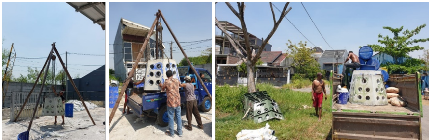
Gambar 8 Proses pengangkatan terumbu buatan dari workshop.
