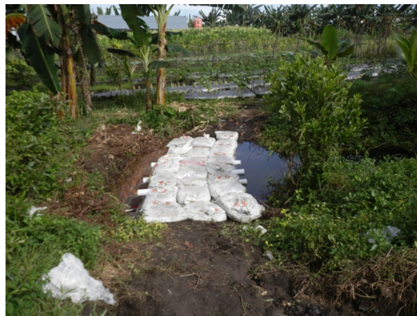
Gambar 6 Bendungan semi permanen untuk warga mitra perikanan.
