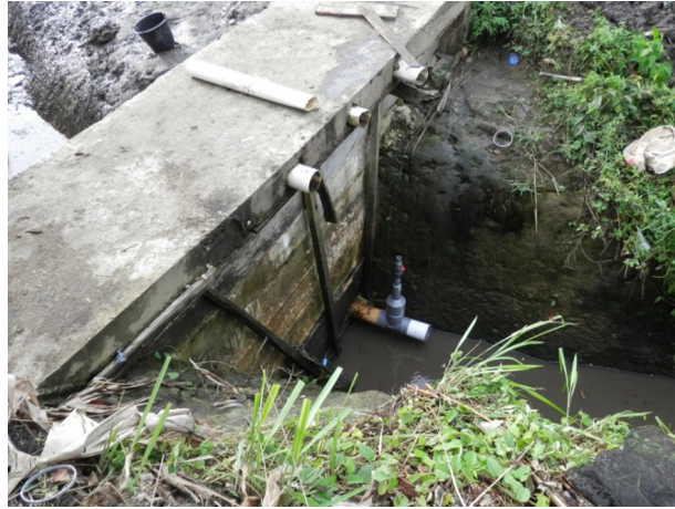
Gambar 9 Saluran air setelah bendungan lengkap dengan adapter.
