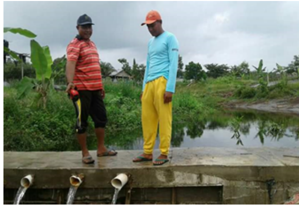
Gambar 11 Instalasi Pipa Buang Bendungan.
