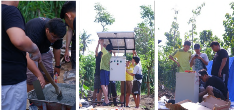
Gambar 5 Proses Pemasangan Alat, dari kiri: Proses pembuatan fondasi oleh tim; pemasangan photovoltaic oleh tim; pengetesan komponen di dalam panel listrik oleh tim.
