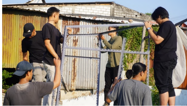
Gambar 12 Pemasangan Mounting untuk Panel Surya.
