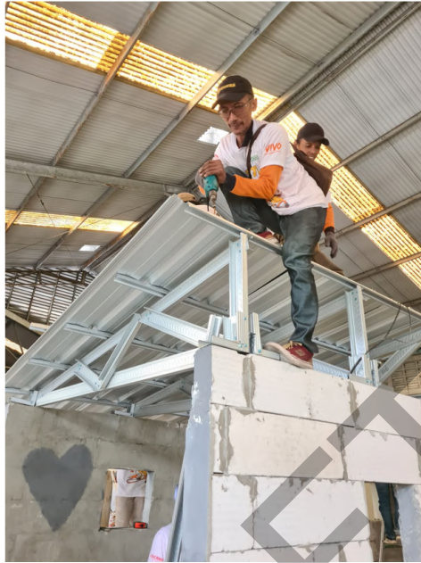
Gambar 8 Praktek Pemasangan Penutup Atap.
