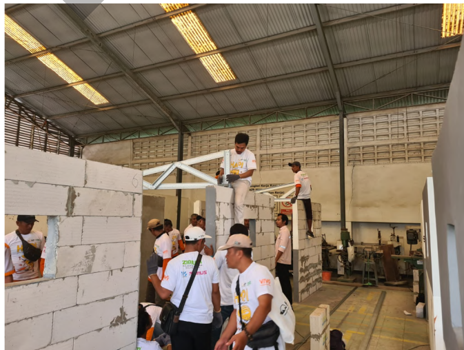
Gambar 7 Praktik pemasangan rangka atap baja ringan.
