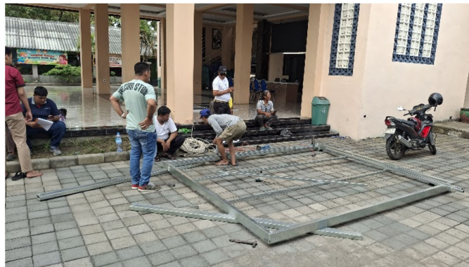
Gambar 7 Pembuatan rangka logam penyangga panel solar sel.
