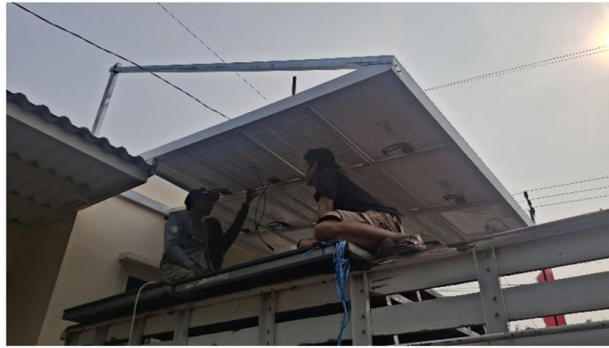
Gambar 8 Pemasangan sistem solar sel di lokasi kegiatan pengabdian masyarakat.
