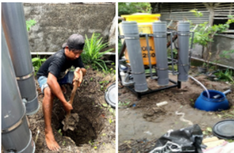
Gambar 7 Proses penggalian tanah untuk tempat bak penampung.
