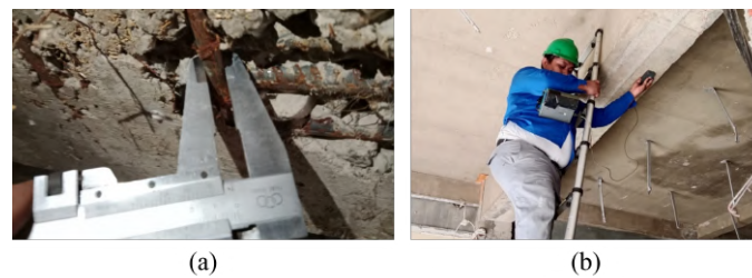
Gambar 5 (a) Pengecekan diameter tulangan kondisi terkini, (b) Pelaksanaan pengujian tebal selimut dan jarak antar tulangan.
