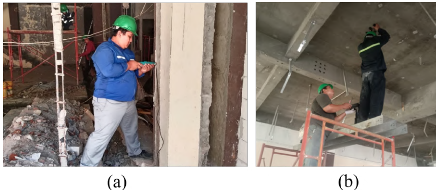
Gambar 3 (a) Pelaksanaan pengujian hammer test , (b) Pelaksanaan pengujian UPV Test.
