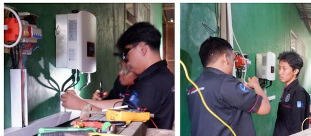
Gambar 13 Instalasi Inverter dan Panel Hubung Bagi.
