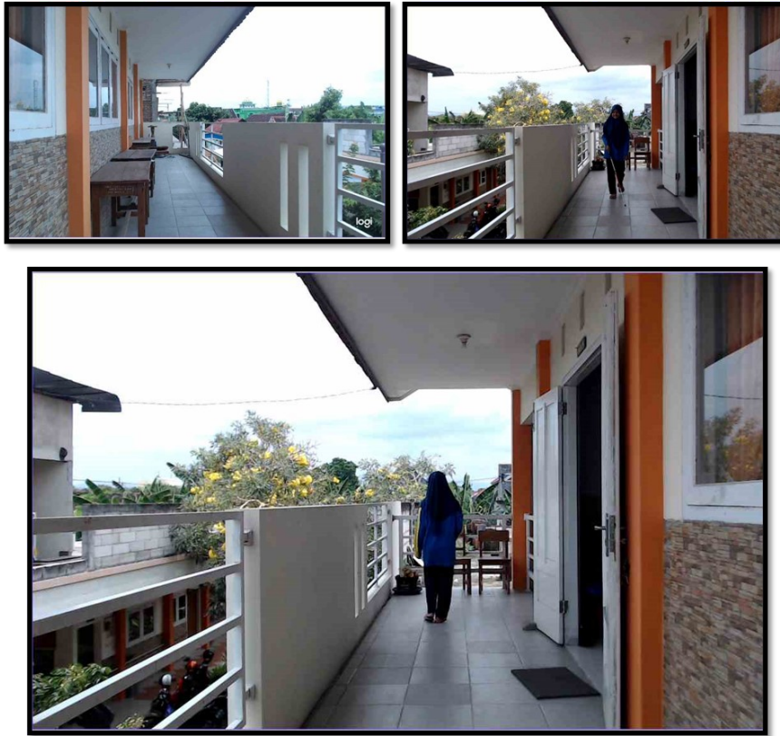
Gambar 2 Salah satu area berbahaya bagi penyandang tunanetra di SLB-A 'Aisyiyah.
