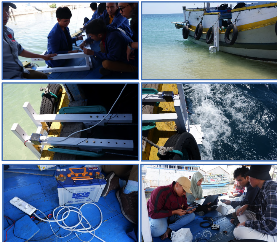
Gambar 13 Pemasangan Mekanisme PLTGL.
