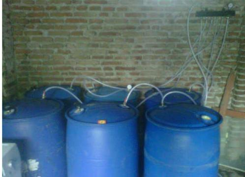
Gambar 6. Seluruh drum (6 buah) yang sudah dirangkai dengan selang plastik
