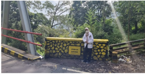
(a) Titik Awal Survei Pendahuluan (KM 70+120)
